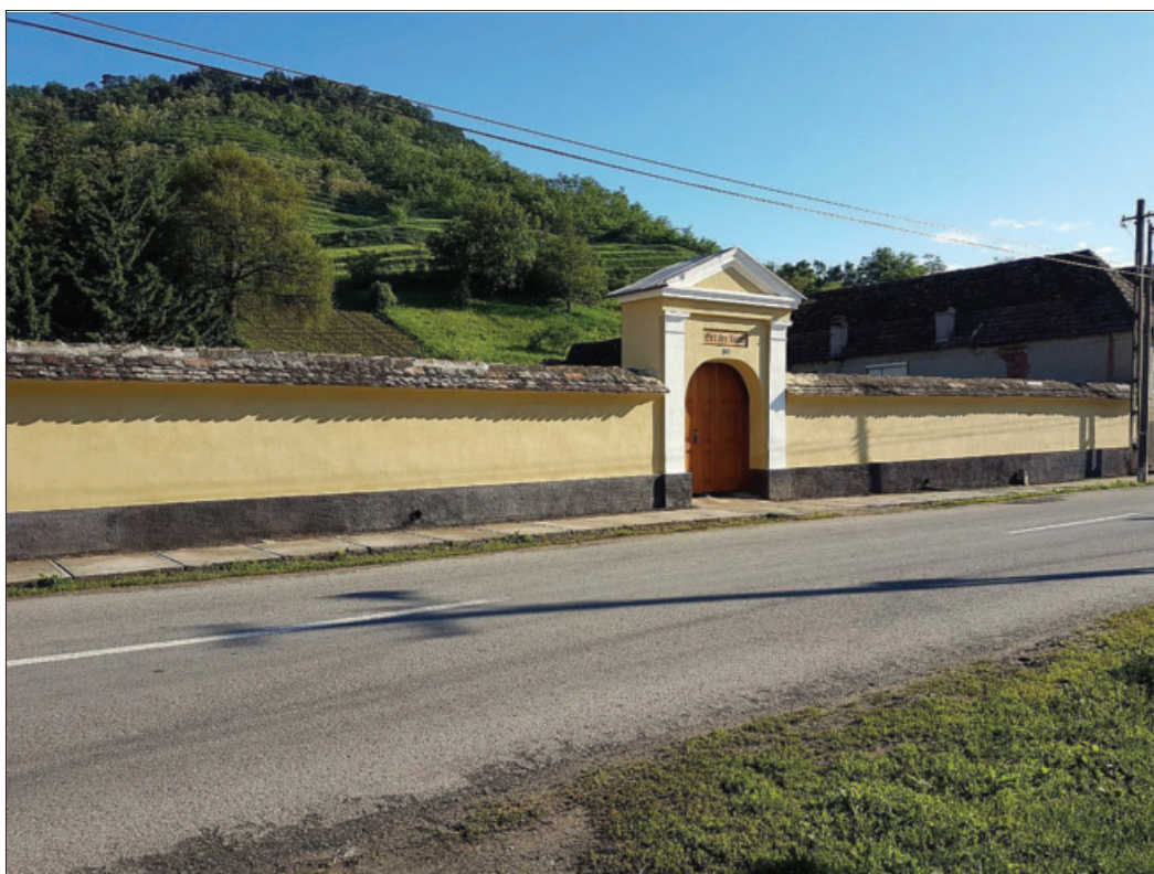
Die renovierte Friedhofsmauer
