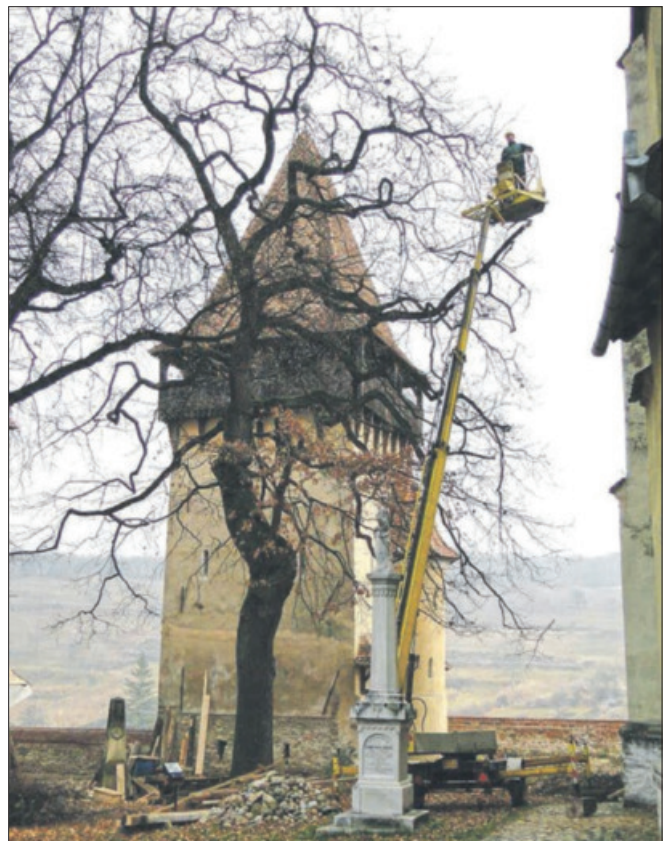
Renovierungsarbeiten an der Kirchenburg Birthälm.
