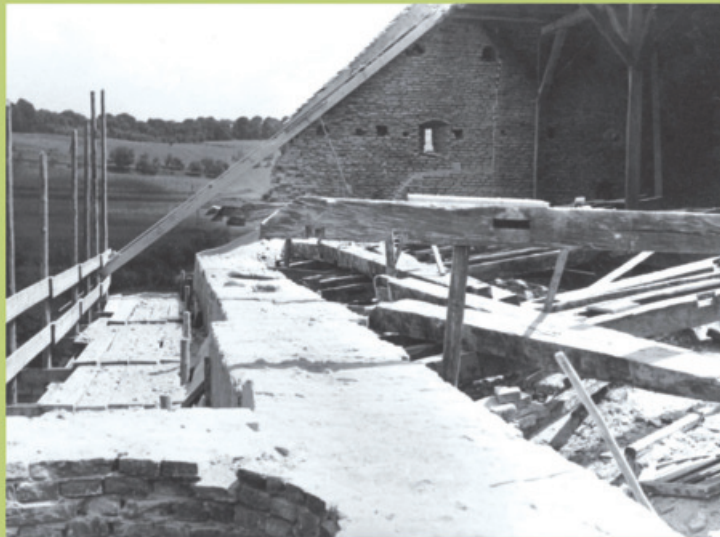
Auf diesem Foto erkennt man den gemauerten Giebel, der sich zwischen dem Dach des Langhauses und dem Chordach befindet und der im Zuge der Renovierungsarbeiten abgetragen wurde, um durch ein Fachwerk mit Dachziegelverkleidung ersetzt zu werden. Vorne links sieht man die Öffnung der Wendeltreppe des nördlichen Türmchens. Im Hintergrund erstreckt sich der Hirsenberg.
