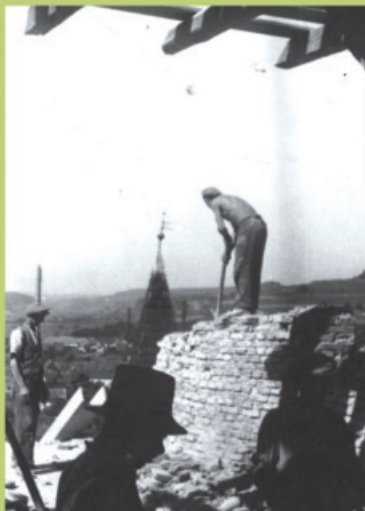
Der Giebel zwischen Langhaus und Chor wird abgetragen. Im Hintergrund ist die Dachspitze des Glockenturms sichtbar.
