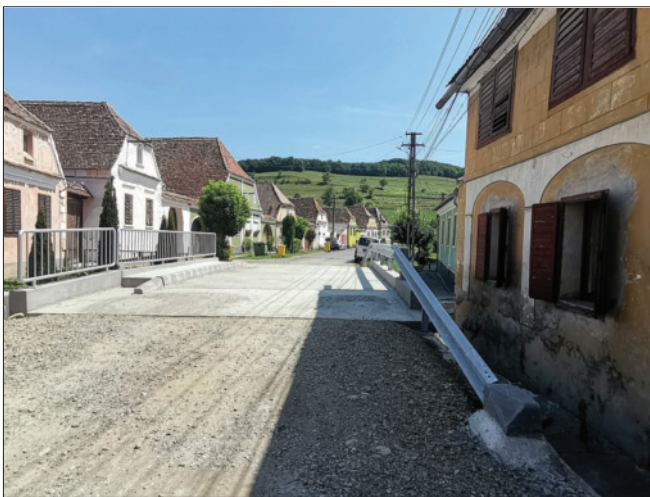
Neue Brücke - Quergasse
