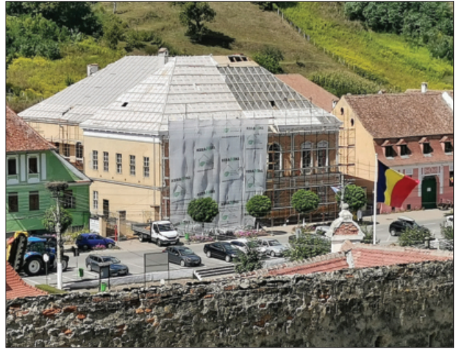
Die Schule auf dem Marktplatz während der Renovierungsarbeiten
