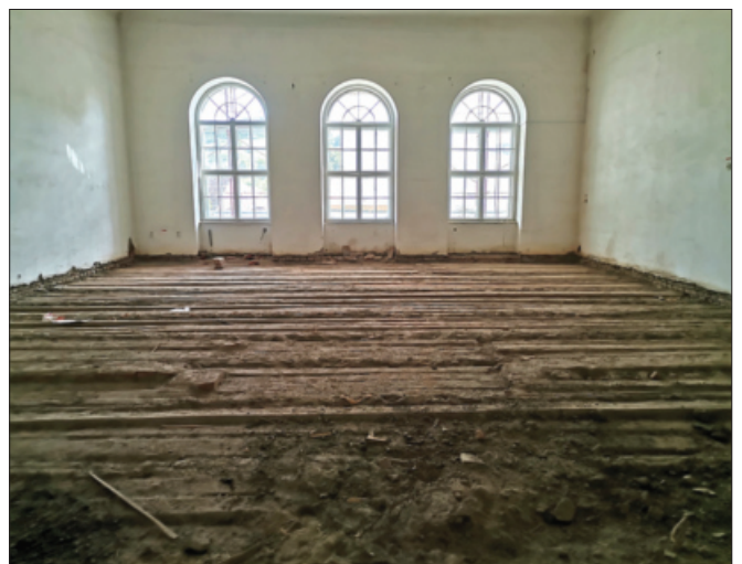
Festsaal während der Renovierungsarbeiten
