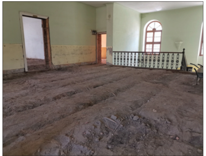
Erster Stock während der Renovierungsarbeiten
