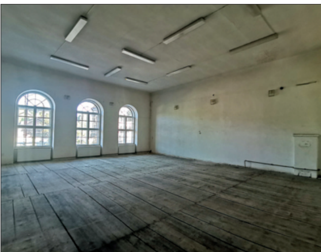
Festsaal vor Beginn der Renovierungsarbeiten
