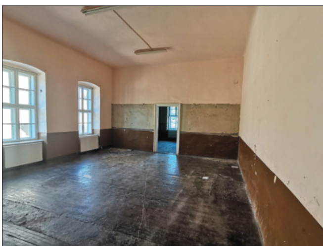
Klassenzimmer vor dem Mauerdurchbruch
