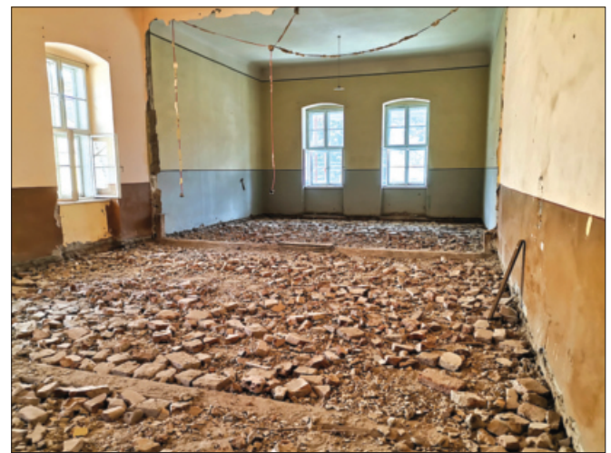
Klassenzimmer nach Mauerdurchbruch
