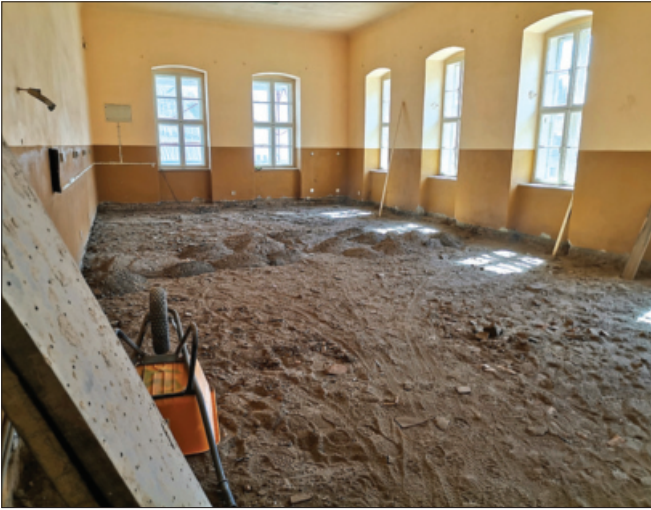
Klassenzimmer während der Renovierungsarbeiten
